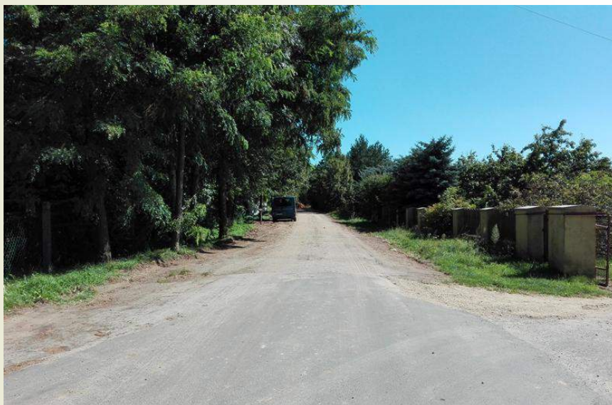
Przebudowana droga Wąsosz-Gola Wąsoska
